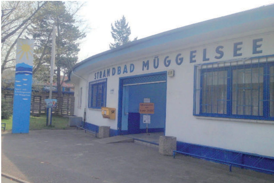
Zusammen und doch getrennt: Die Gebäude und ...
